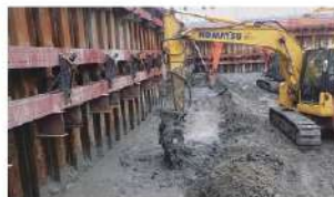
機械攪拌機での施工
