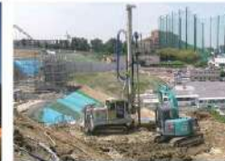
機械攪拌機での施工
