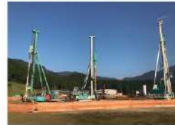
機械攪拌機での施工
