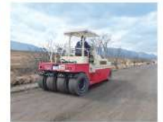
転圧ローラーでの転圧
