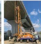
機械攪拌機での施工
