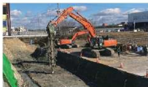
機械攪拌機での施工
